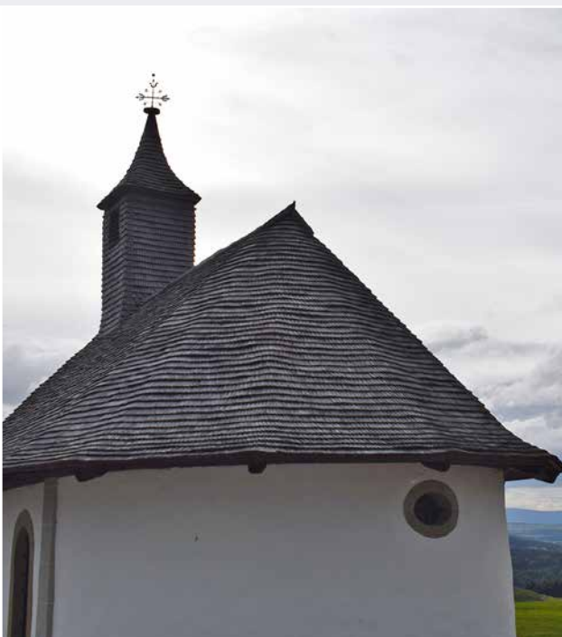
Le clocheton et la toiture en tavillons
